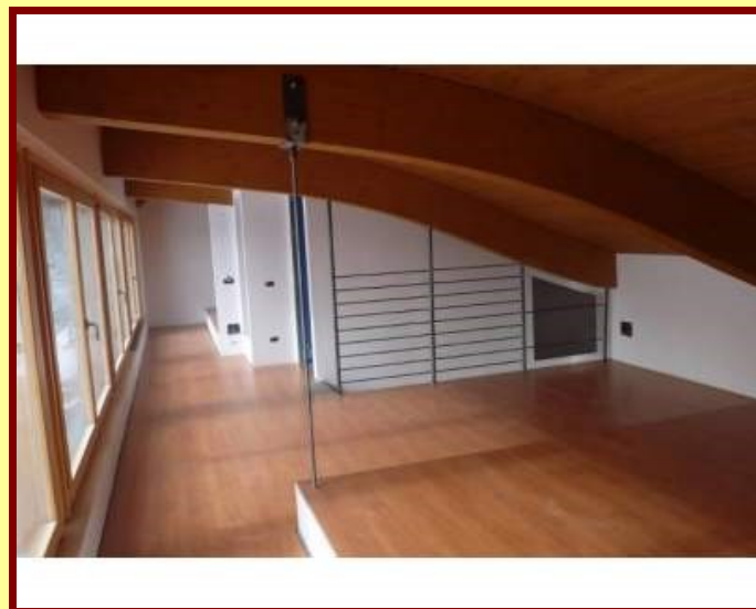
Particolare del tetto visto dall'interno dell'abitazione.
