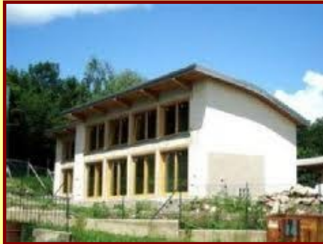
Immagine della facciata rivolta a sud, con grandi aperture.
